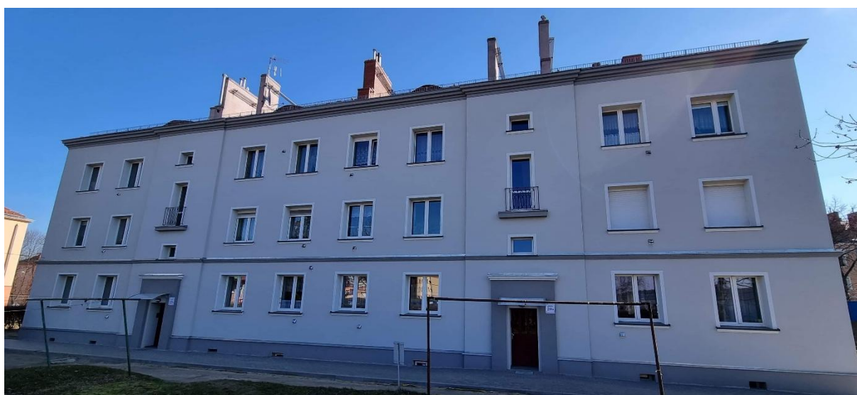
Wojska Polskiego 28 – termomodernizacja budynku
