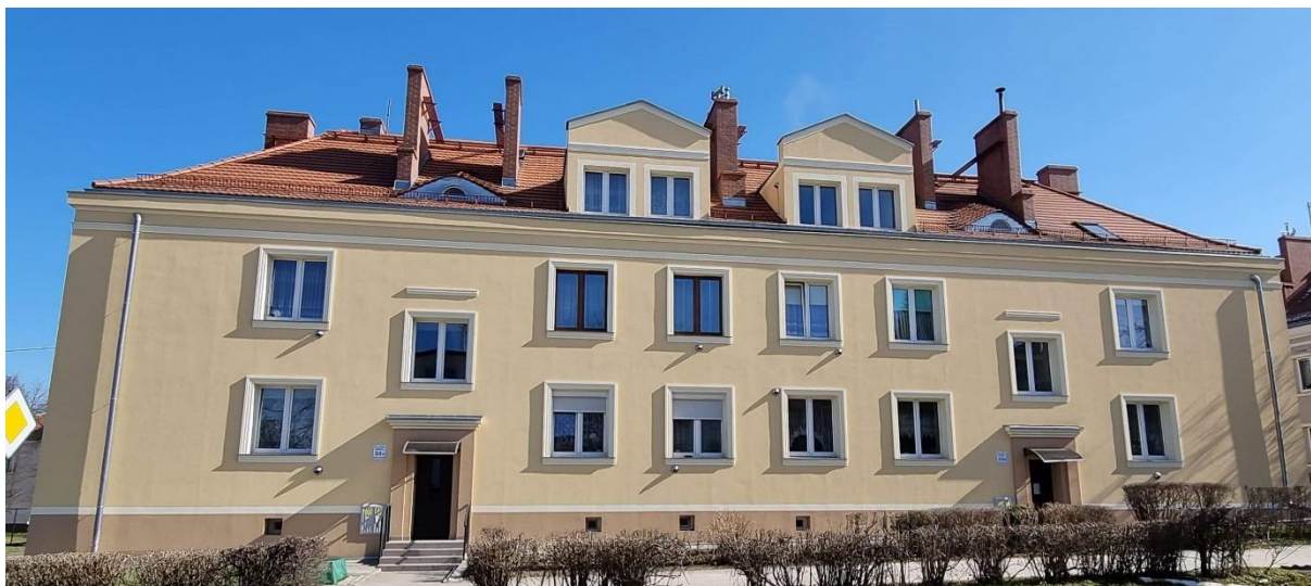
Wojska Polskiego 33 – remont elewacji, kl. schodowych, izolacja ścian fundamentowych
