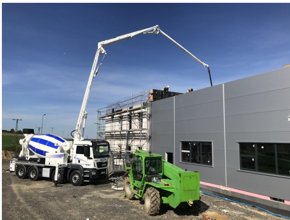
Budowa hali modułowej.
