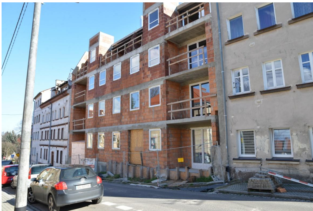
Budowa budynku mieszkalnego w systemie TBS przy ul. Klasztornej
