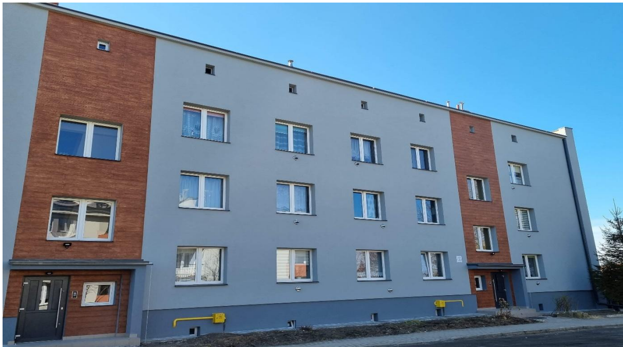
Wojska Polskiego 12 – termomodernizacja budynku – wartość 450.000 zł
