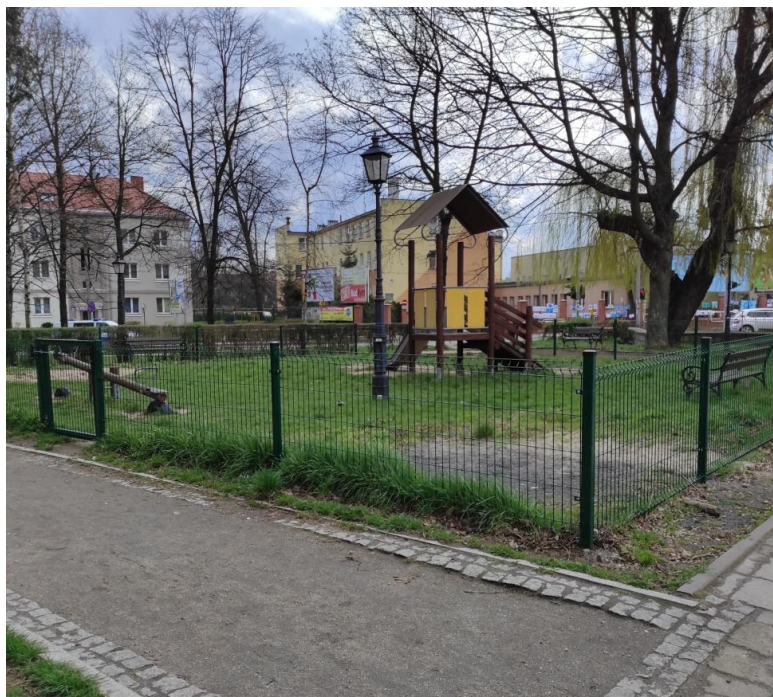
Budowa i wymiana ogrodzeń przy placach zabaw.
