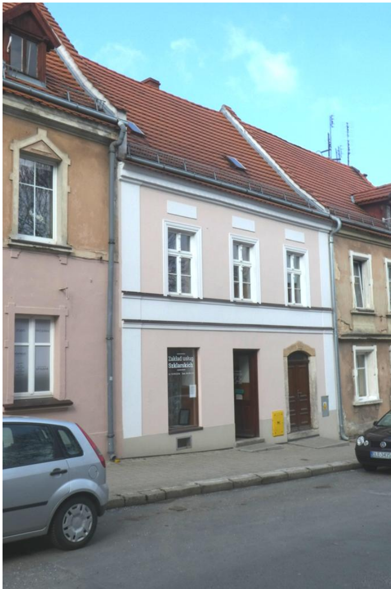
Wyremontowana kamienica przy pl. Matejki 3
